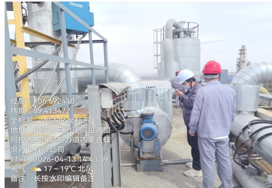
现场验收照片
