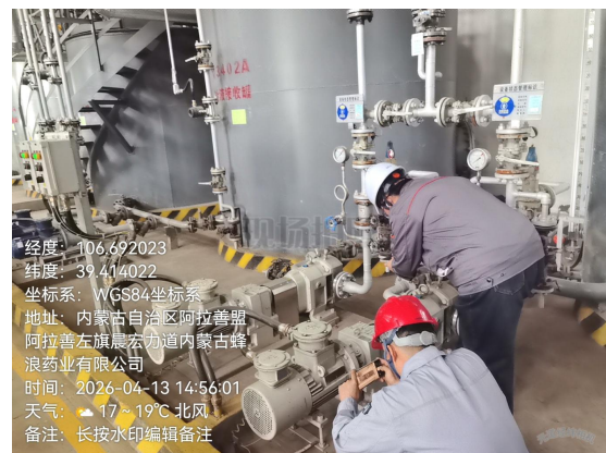
现场验收照片
