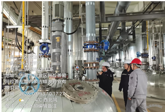
现场验收照片
