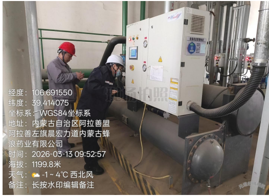
现场验收照片
