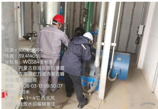
现场验收照片
