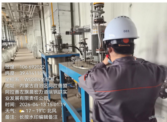
现场验收照片
