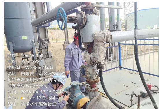
现场验收照片
