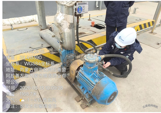
现场验收照片
